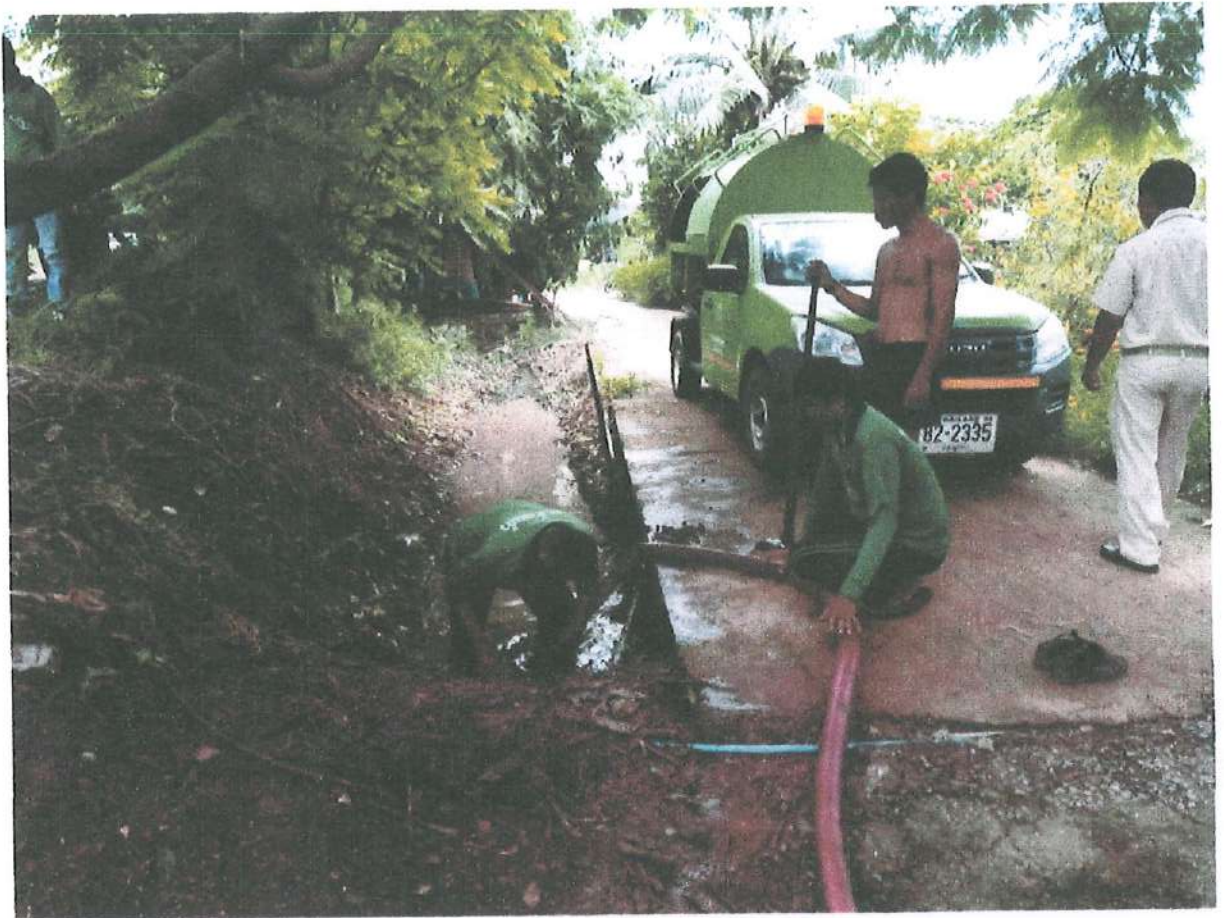
รูปการดำเนินการเป่าท่อระบายน้ำในพื้นที่ หมู่ที่ ๘ ตำบลบางกระทุ่ม
