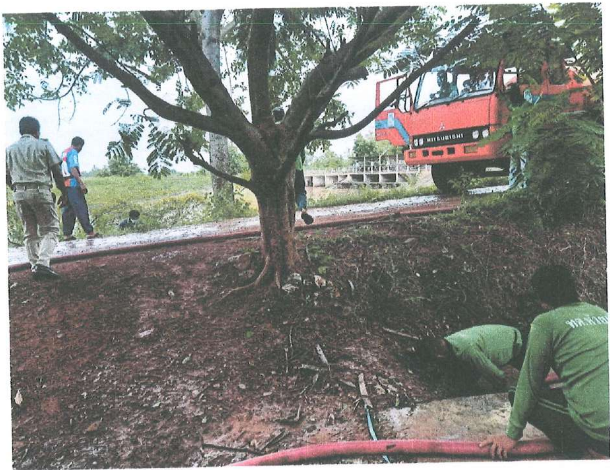
รูปการดำเนินการเป่าท่อระบายน้ำในพื้นที่ หมู่ที่ ๘ ตำบลบางกระทุ่ม
